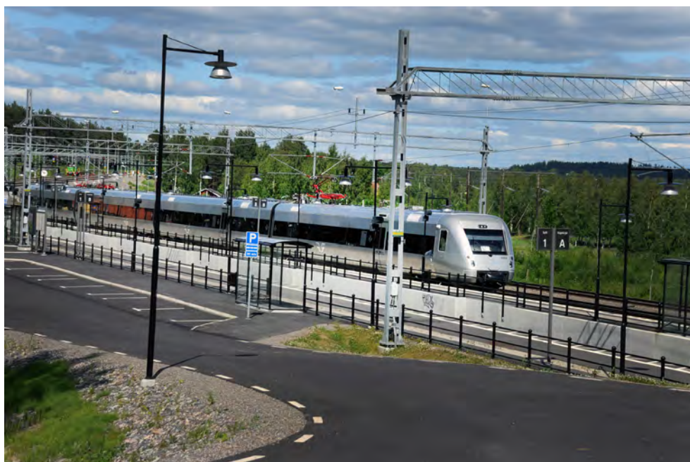
Det behövs en ny järnväg mellan Sundsvall och Härnösand.
