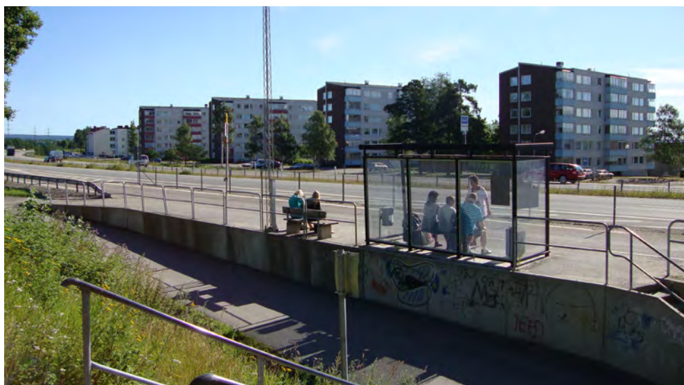
Vy från befintlig motorvägshållplats vid Timrå centrum.
