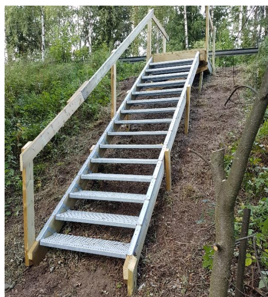
Bild 3: Byggd trapp vid Y:et.
