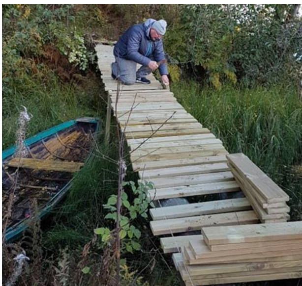
Bild 2: Byggande av bro efter etapp 1.
