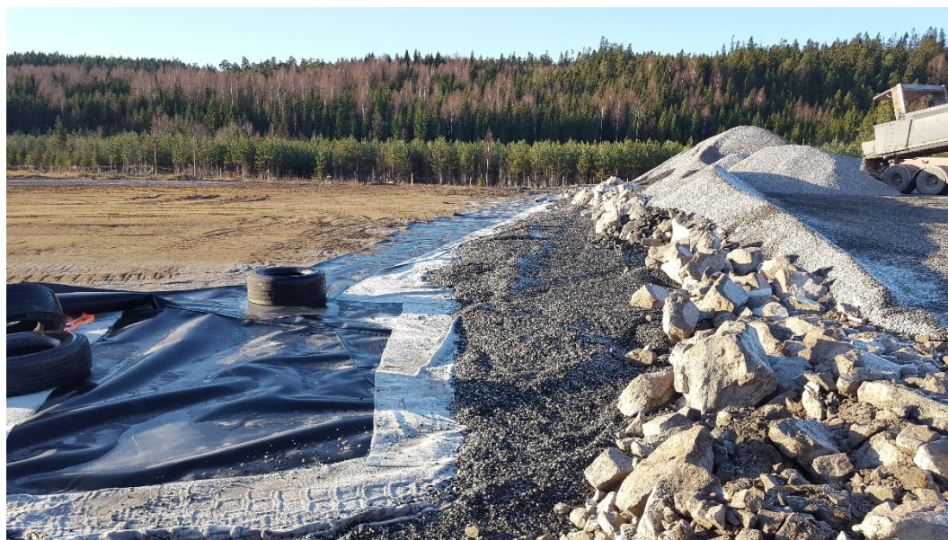
Bild 3 . Utläggning av tätskikt och skyddstäckningskitt på deponin november 2017
