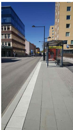
Bild på hållplatslösning från Storgatan i Sundsvall. Hållplatsen ligger vid körbanan med gc-väg bakom väderskyddet.
