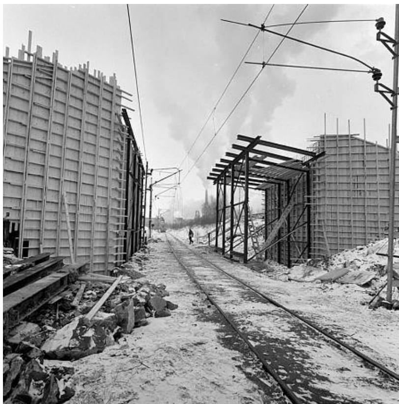
Figur 6.2. Foto från 1980. Brobygget över järnvägen till massafabriken pågår.
