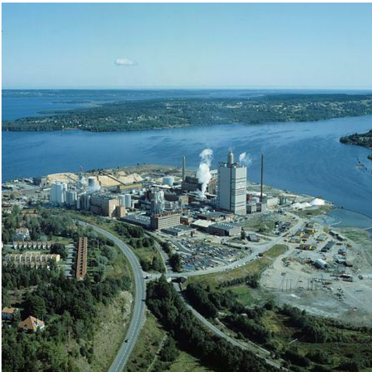
Figur 7.5. Foto från 1982 efter skredet med nya infarten på bro över järnvägen till nybyggd fabrik.
