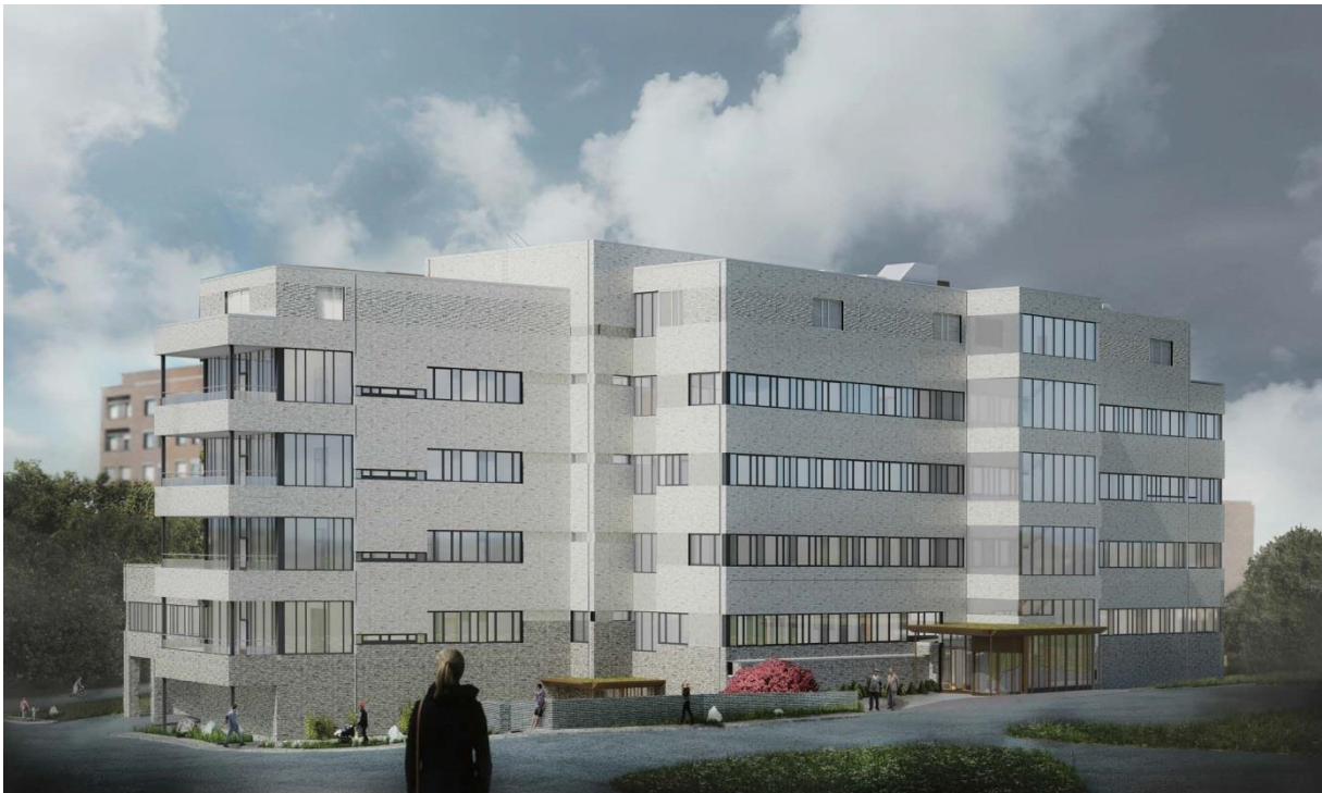
Bild 3 – Byggnad 46 östra fasaden med besöksentré
