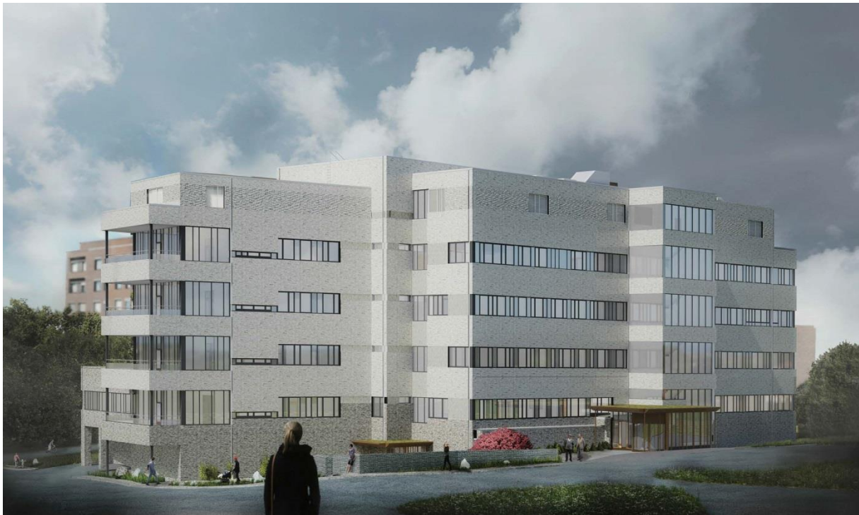
Bild 3 – Byggnad 46 östra fasaden med besöksentré
